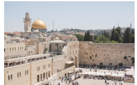
いまのこ 今も残っている外壁(嘆きの壁)
